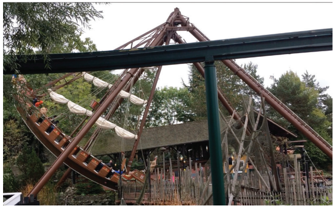
Abbildung 7: Das Pendelfahrgeschäft Vindjammer im Europa-Park hat eine Pendellänge von etwa 13 m.
